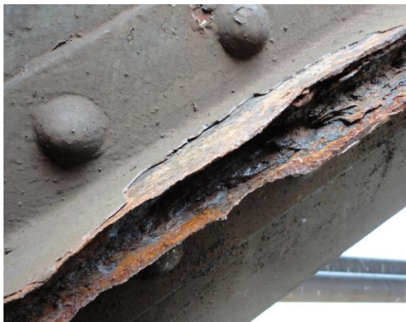
TYPICKÁ ŠTĚRBINOVÁ KOROZE DIAGONÁLY
