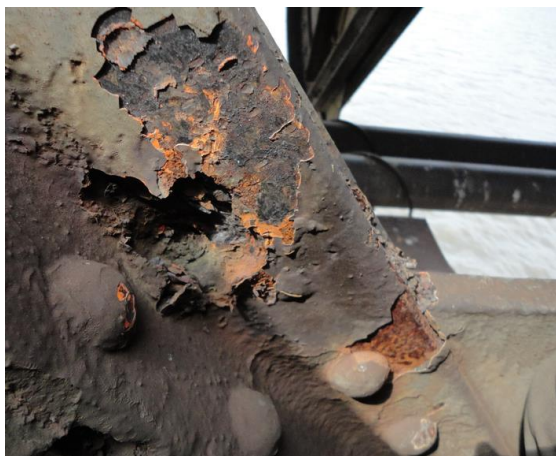
TYPICKÁ KOROZE DIAGONÁLY V MÍSTĚ STYČNÍKU S DOLNÍM PÁSEM
