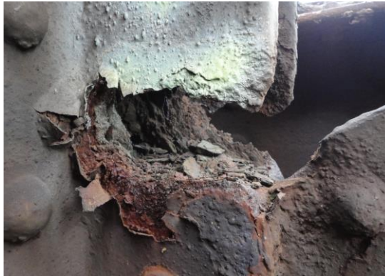
TYPICKÁ ŠTĚRBINOVÁ KOROZE SVISLICE
