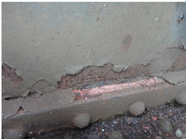
TYPICKÁ KOROZE KRČNÍCH ÚHELNÍKŮ PŘÍČNÍKU
